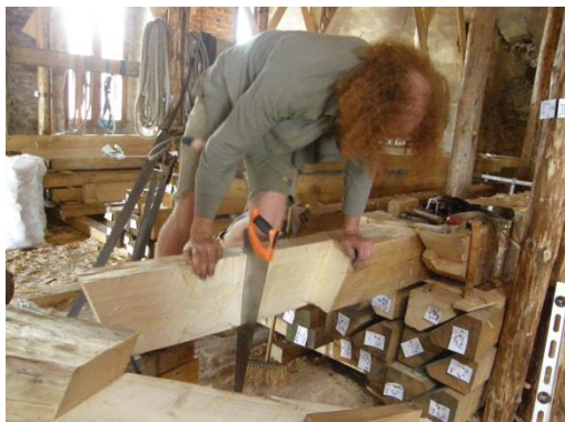
Obr. 29 Příprava drážky pro hmoždík pomocí ruční pily
