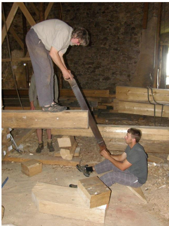
Obr. 23 Ruční řezání podélného plátu tažnou dvoumužnou pilou (vlevo)
