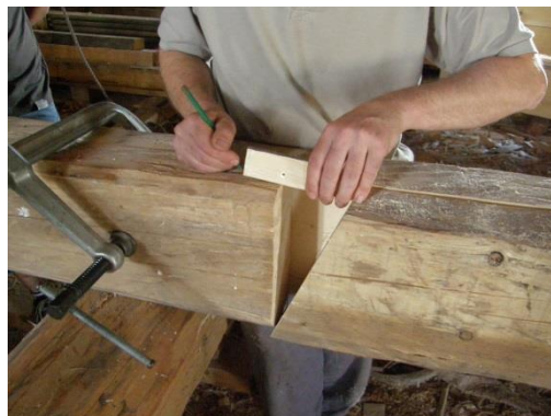
Obr. 30 Orýsování šikmého čela z již zajištěného protikusu
