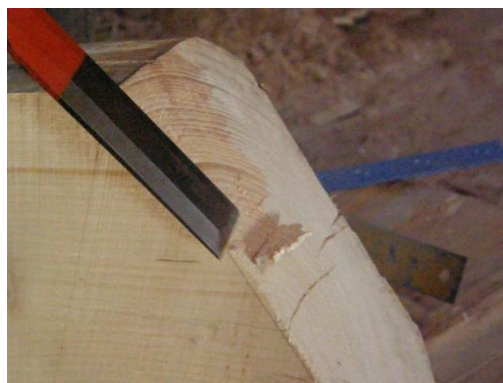
Obr. 32 Osekání nadbytečné délky plátu
