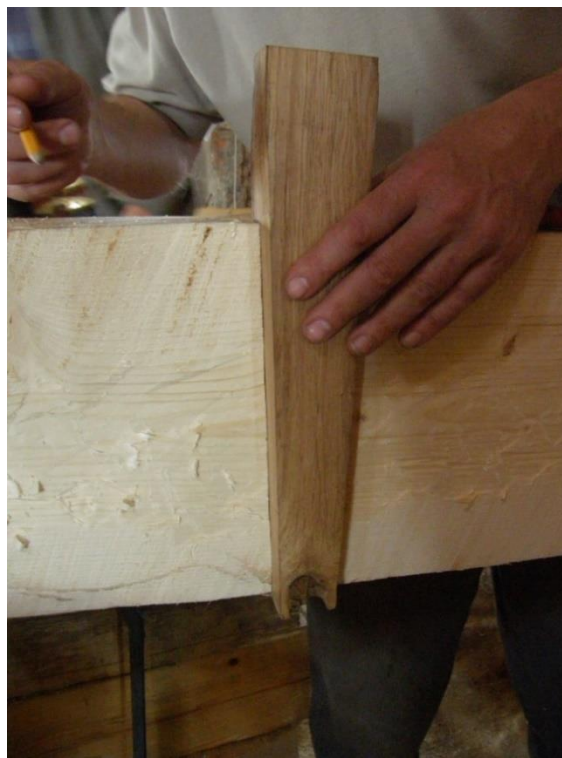
Obr. 34 a) Vyřeznutí drážky pro hmoždík s odsazením umožňujícím rozpěr čel při dotabování hmoždíku (je zvýrazněno barevně; vlevo nahoře), b) kontrola osazení hmoždíku v drážce (vpravo), c) výroba drážky pro hmoždík přímo při sesazení spoje (vlevo dole)
