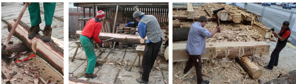
Obr. 41 Vrubování (vlevo, uprostřed) [16], hrubování (vpravo)
