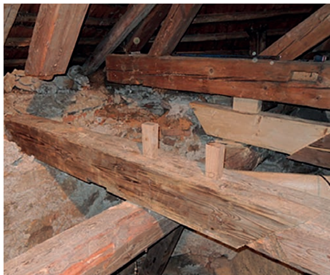
Obr. 6 – Dvouhmoždíkový spoj zajištěný kolíkem použitý při opravě na zámku v Lanškrouně (vlevo) a tentýž spoj použitý na krovu kostela v Červené vodě (vpravo)
