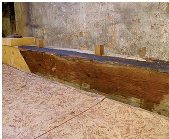
Obr. 6 – Dvouhmoždíkový spoj zajištěný kolíkem použitý při opravě na zámku v Lanškrouně (vlevo) a tentýž spoj použitý na krovu kostela v Červené vodě (vpravo)
