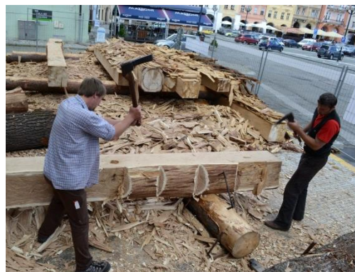
Obr. 73 Vrubování (vlevo) [28], hrubování (vpravo)
