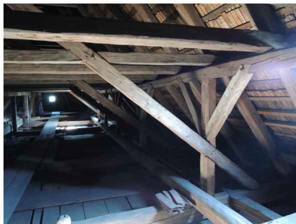
Obr. 62 Boční podélné vázání barokního krovu kostela v Červené Vodě
