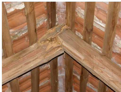
Obr. 6 Biologické napadení spoje
