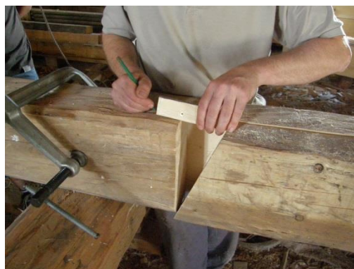
Obr. 43 Orysování šikmého čela z již zaříznutého protikusu
