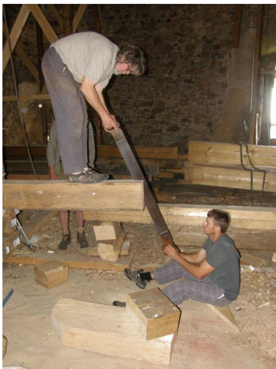
Obr. 36 Ruční řezání podélného plátu tažnou dvoumužnou pilou (vlevo)
