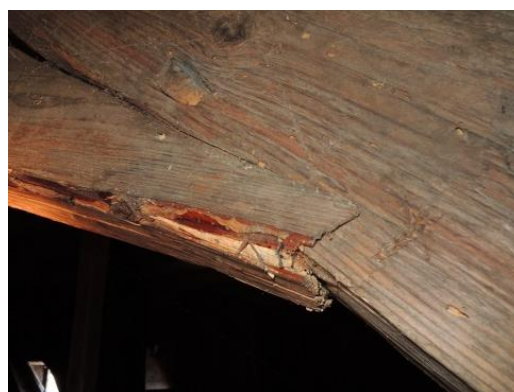
Obr. 2 Tlak šikmo k vláknům (pásek na sloupek)
