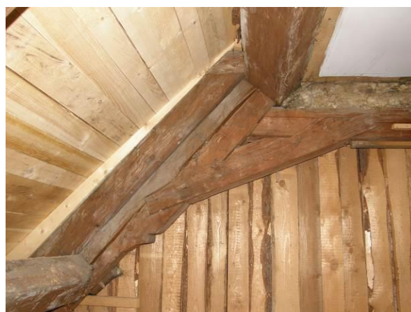
Obr. 53 Detail části příčné vazby barokního krovu zámku v Lanškrouně
