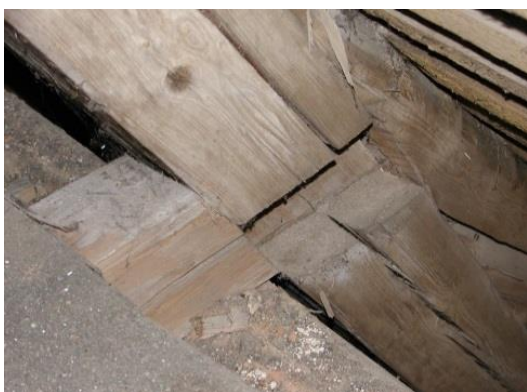
Obr. 7 Záměrné změny – chybný spoj
