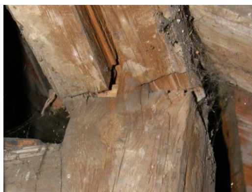
Obr. 4 Tah kolmo k vláknům
