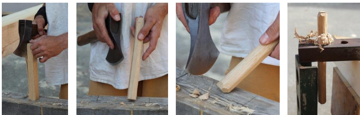
Obr. 28 Postup výroby kolíků
