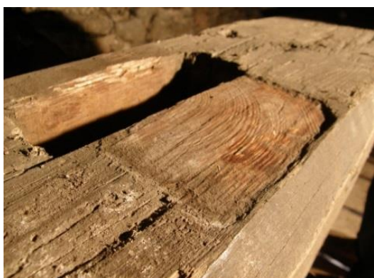
Obr. 1 Tlak kolmo k vláknům (původní pata sloupku)
