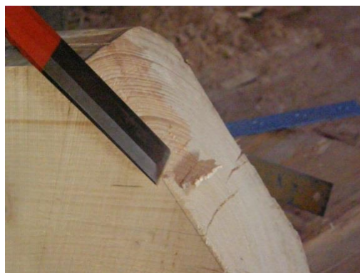
Obr. 45 Osekání nadbytečné délky plátu
