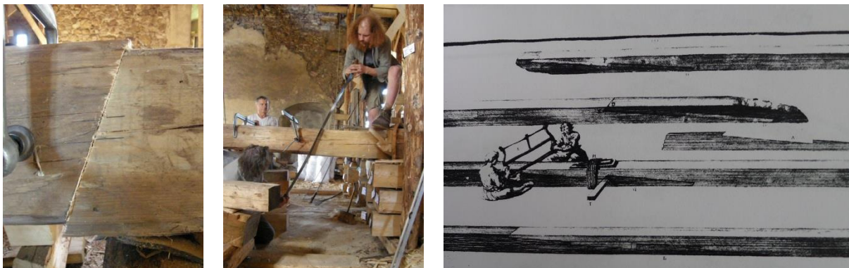
Obr. 46 a) Spasování čela spoje, b) prořezávání ruční pilou c) prořezávání čel spoje v díle [33]
