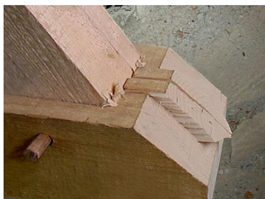
Obr. 3 Podélný smyk
