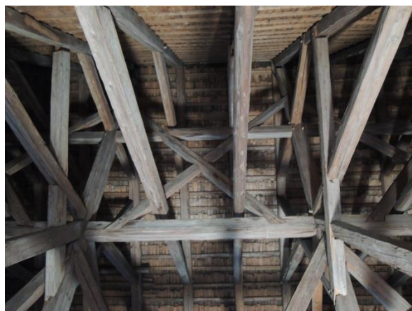
Obr. 64 Detail podélného zavětrování ve střední části barokního krovu kostela v Červené Vodě
