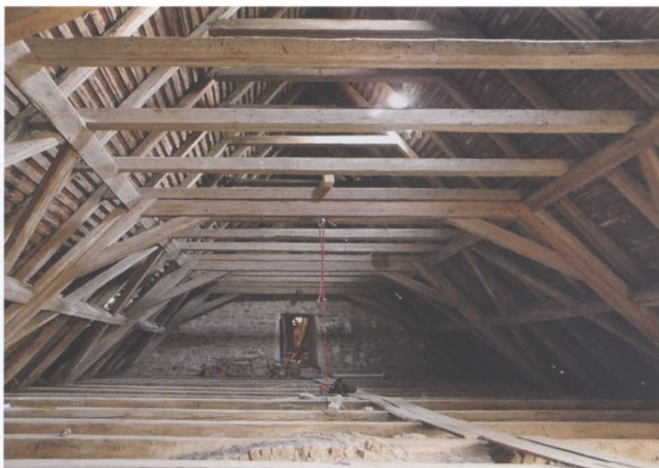
Obr. 2. Krov nad hlavní lodí – příčné vazby. (Foto Michal Kloiber, 2011)
