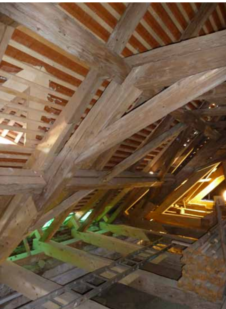
▼ Obr. 1. Rekonstrukce krovu kostela Nanebevzetí Panny Marie ve Vranově nad Dyjí
