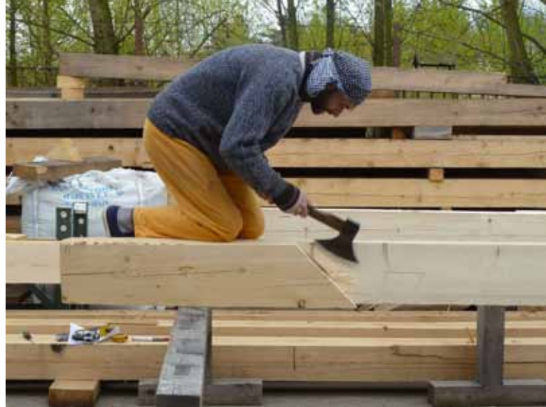
▲ Obr. 4. Velká část práce se v minulosti dělala sekerou – dočištění šikmého čela plátového spoje
