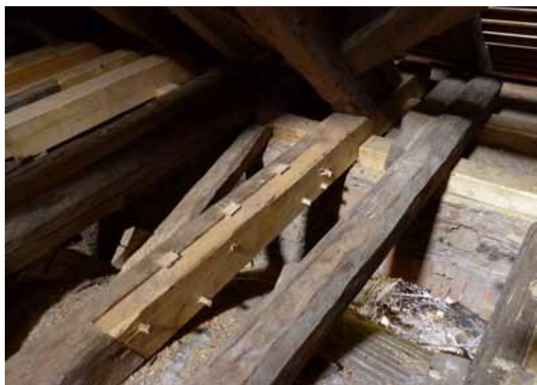
▼ Obr. 2. Použití plátového spoje při rekonstrukci krovu kostela sv. Markéty v Šonově na Broumovsku
